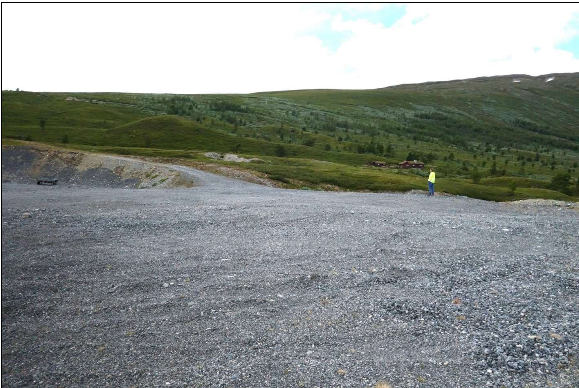
Foto frå planområdet 03.07.24. I det gamle grustaket er det lagra knuste masser for framtidig bruk på veganlegget – lokalisert til område R1 på plankartet. Foto: Ø. Pedersen
