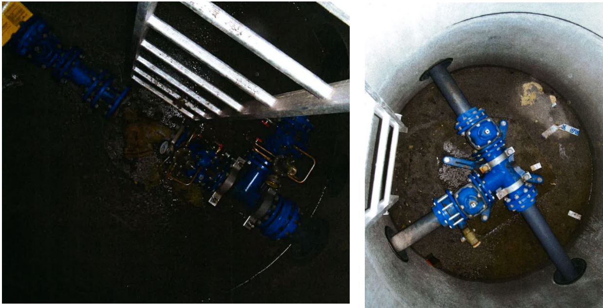
Figur 4 – Eksisterende vannkum K1126 til venstre og K1125 til høyre
