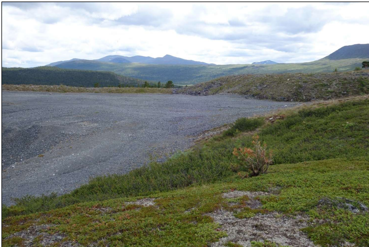
Foto: Bilde som viser steinmassane som er lagra i den gamle grusgruva - område R1 i forslaget til reguleringsplan. Det høgare partiet i til høgre bak den grå flata, er det permanente massedeponiet – område KLM1 i planforslaget.
