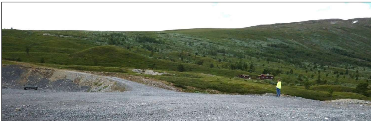
Foto: Areala bak personen på bildet omfattar områda R2 og R3 i reguleringsplanforslaget, som blir føreslege opna foruttak etter at den lagra grusen i område R1 er teke ut. Dei nye uttaksareala strekk seg ca. 30 m ut frå veggen som går ned i området.
